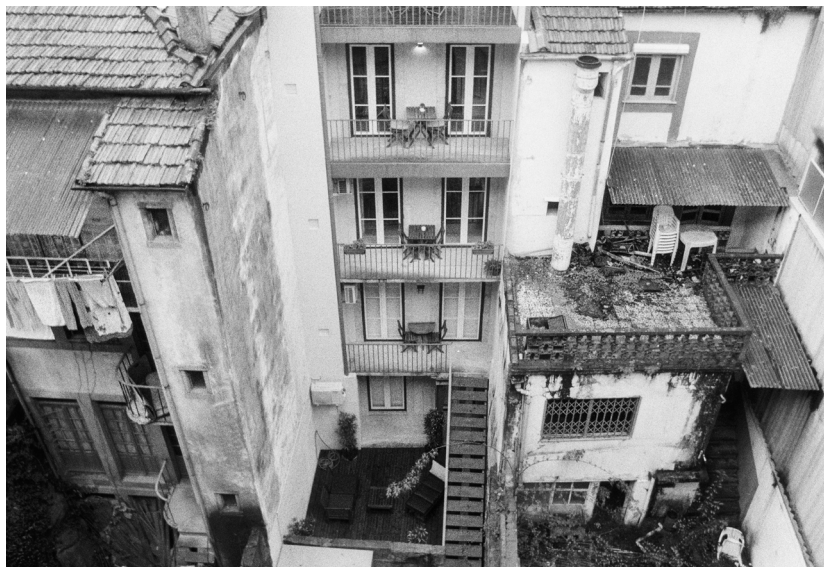
Tardoz de um alojamento local na Rua do Almada. Foto tirada da antiga sede do Futebol Clube do Porto, em requalificação para hotel Avenida dos Aliados
